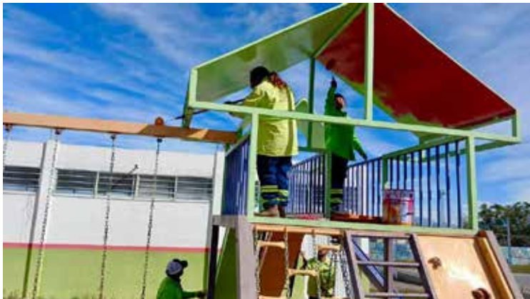
LOS TRABAJOS DE pintura se realizaron en juegos, canchas y bancas.
