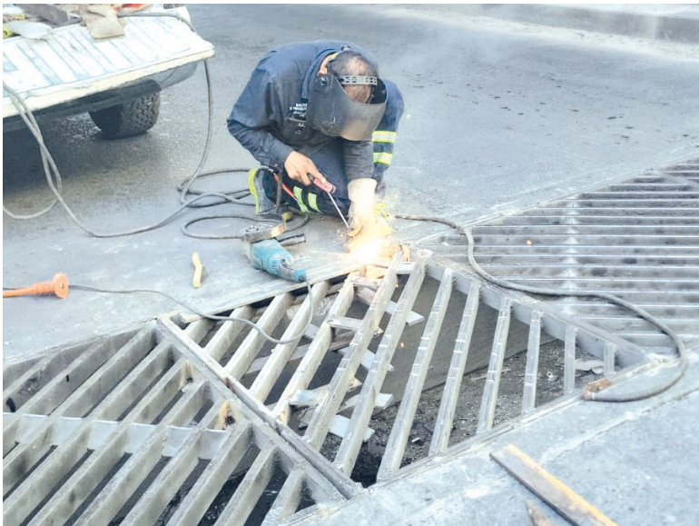
ESTAS ACCIONES FORMAN parte de la estrategia integral de mantenimiento que impulsan el Gobernador Manolo Jiménez y el Alcalde Javier Díaz, para conservar en óptimas condiciones la infraestructura vial.
