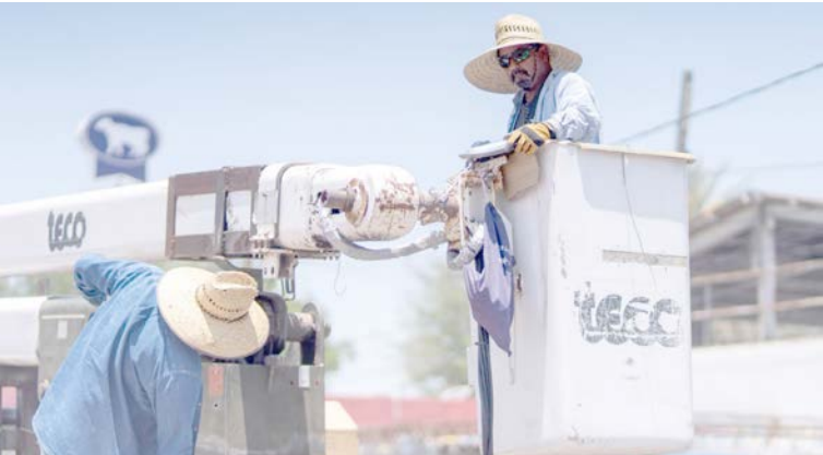
BRIGADAS DE IMAGEN Urbana reemplazaron antiguas estructuras públicas.
