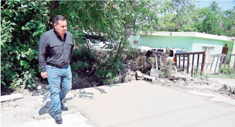
LA REHABILITACIÓN YA terminó, aunque el paso permanecerá restringido mientras se realizan trabajos finales para garantizar condiciones seguras a todos los usuarios expresó el Edil.
