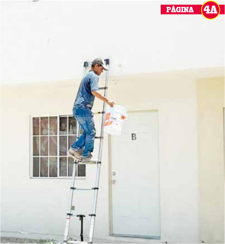
REPARAN DAÑOS EN casas nuevas del Bienestar tras desperfectos registrados por las lluvias.
