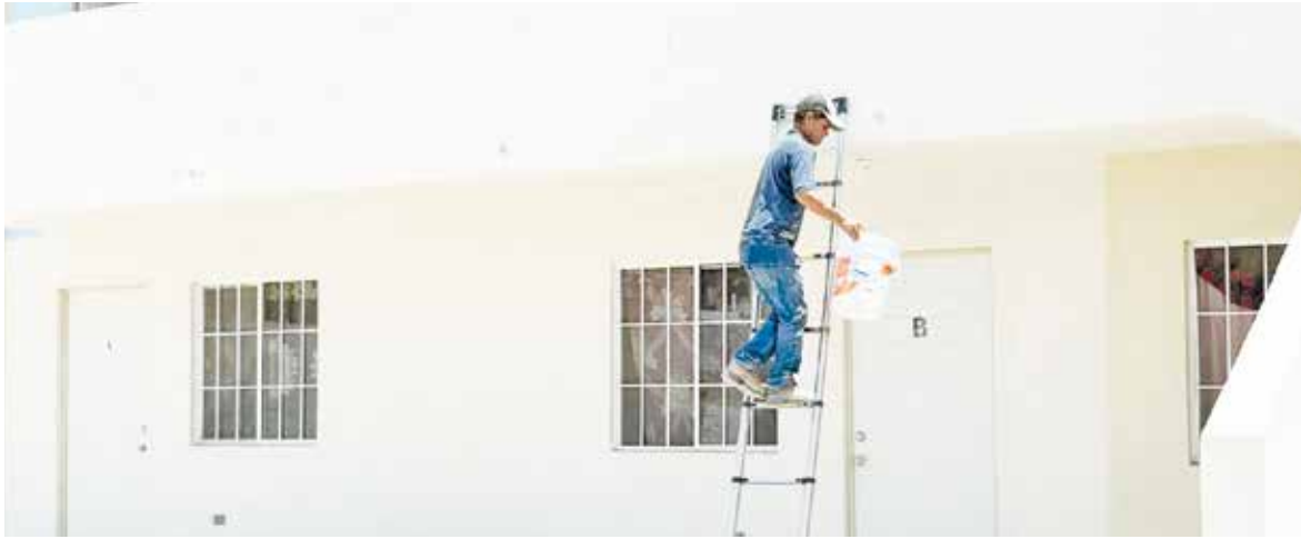
REPARAN DAÑOS EN casas nuevas del Bienestar tras desperfectos registrados por las lluvias.
