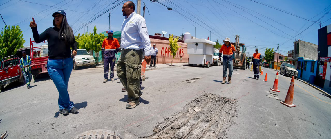
POR INSTRUCCIONES DEL Alcalde Tomás Gutiérrez Merino, personal especializado inició la intervención de índole preventiva de la red de drenaje sanitario en el cruce de los bulevares Jaime Benavides Pompea y Del Valle.
