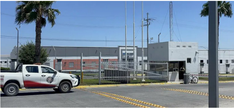
EL TÉCNICO MANIPULABA un contactor cuando recibió una fuerte descarga que lo dejó inconsciente.
