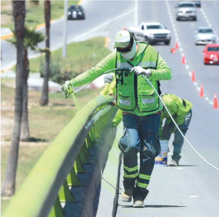
EL ALCALDE JAVIER Díaz señaló que estas labores ayudan a mejorar la visibilidad de la infraestructura y a reforzar la seguridad de quienes transitan diariamente por esta vialidad.
