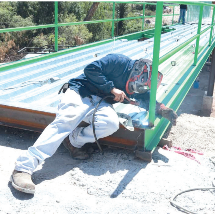
JAVIER DÍAZ DESTACÓ el apoyo del Gobernador Manolo Jiménez en la construcción de esta infraestructura, en la que se invierten 2.5 millones de pesos.
