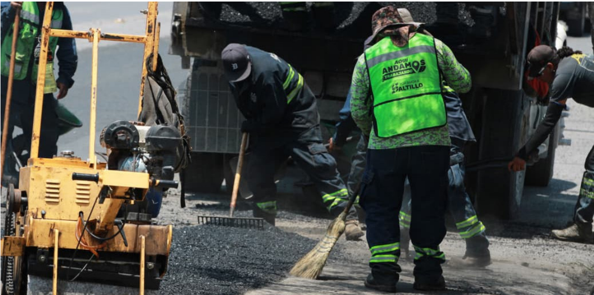
DE MANERA SIMULTÁNEA y para fortalecer la movilidad en la ciudad, personal de “Aquí Andamos” rehabilitó diferentes puntos del pavimento deteriorado sobre el Bulevar Francisco Coss.
