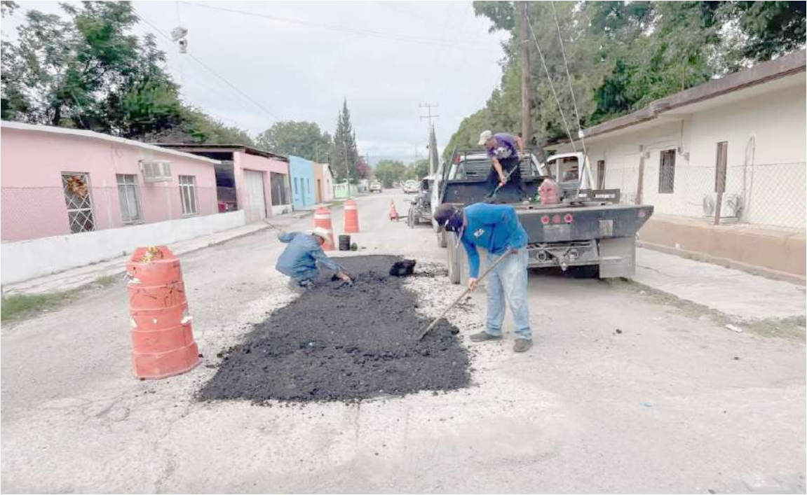
TRABAJOS CONTINUARÁN DE forma progresiva en las comunidades.
