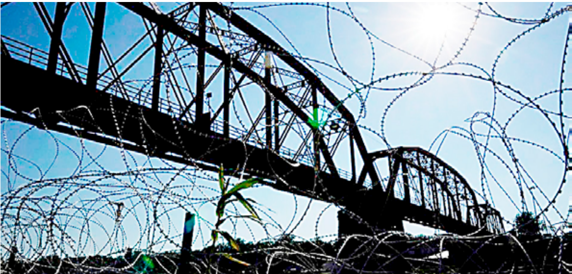
LA NUEVA REGULACIÓN exige un nivel adecuado del idiota para reaccionar ante emergencias, aunque todavía no todavía no entrará en vigor de inmediato, ya que debe ser regulada por la Administración Federal de Ferrocarriles.
