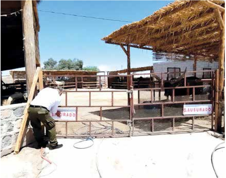
ANTE LAS IRREGULARIDADES se ordenó la clausura temporal total de la operación y actividades en el predio.
