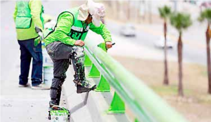
CUADRILLAS MUNICIPALES CONTINÚAN con los trabajos de aplicación de pintura en las barreras de contención y sus soportes ubicados sobre el Bulevar Fundadores.
