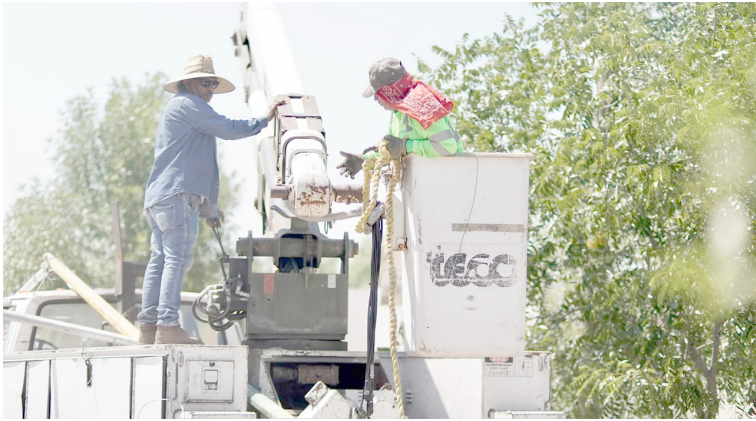
PERSONAL DE SERVICIOS Primarios revisa líneas eléctricas y sustituye equipo en diversas calles del sector.
