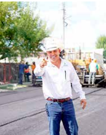
LA PAVIMENTACIÓN DEL sector brinda mayor seguridad, fluidez y calidad de vida para los residentes de la zona.
