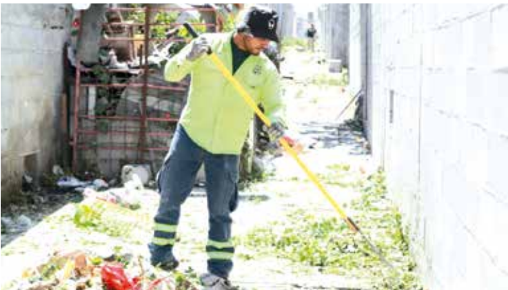
CUADRILLAS DEL PROGRAMA “Aquí Andamos” realizaron trabajos de limpieza integral y profunda en diversos callejones de la colonia Vicente Guerrero.
