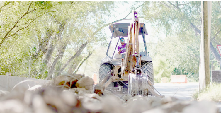
MAQUINARIA PESADA COLOCARÁ la malla electrosoldada de refuerzo antes de efectuar el vertido final de la losa a mediodía.
