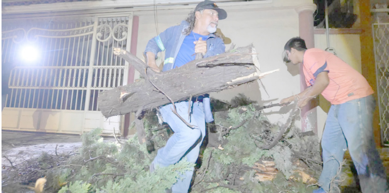
CUADRILLAS MUNICIPALES TRABAJAN simultáneamente en la limpieza y retiro de estructuras y árboles caídos.
