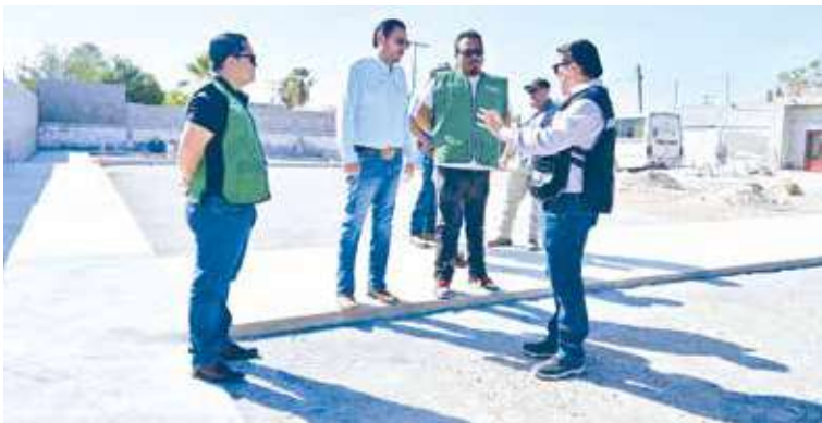
EL ALCALDE CARLOS Villarreal supervisó los avances de la construcción del área verde en la colonia San Salvador, obra que representa una inversión superior a 1.9 millones de pesos.
