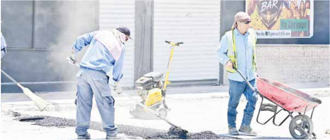
DURANTE LA SEMANA se repararon 744 baches y 46 roturas de SIMAS, abarcando más de 1,200 metros cuadrados.
