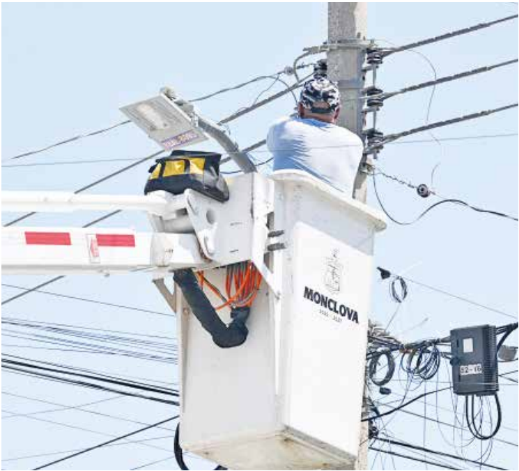
EL AYUNTAMIENTO DE Monclova instaló 15 luminarias LED sobre la avenida Las Torres.
