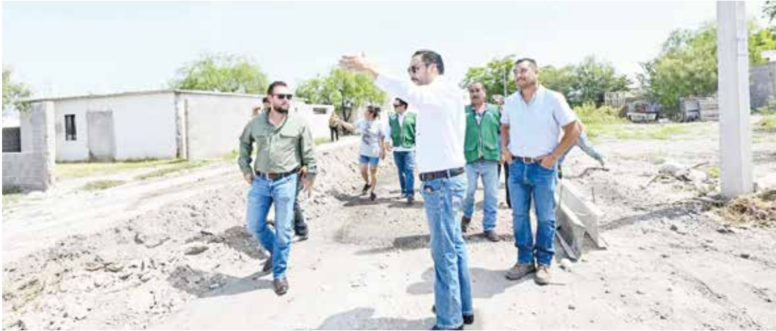
CARLOS VILLARREAL SUPERVISÓ la obra de pavimentación de la calle Piñones (Valle Acatlán), entre Nísperos y el tope de calle, en la colonia Del Río, con una inversión superior al millón de pesos.
