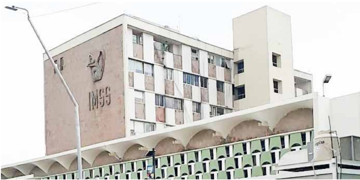
FAMILIARES DE PACIENTES de Clínica 7 del Seguro Social denuncian falta de aire acondicionado.
