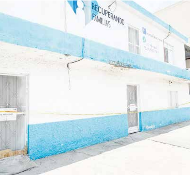
EL ANEXO “RECUPERANDO Familias” fue clausurado luego de que autoridades detectaran sobrecupo, falta de higiene, ausencia de permisos y diversas irregularidades sanitarias.
