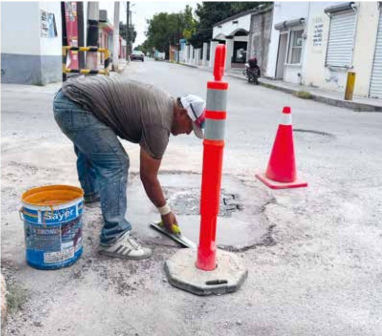
LA REHABILITACIÓN DE una caja de válvulas permitió nivelar el pavimento y ofrecer mayor seguridad a quienes circulan diariamente por la zona centro de San Buenaventura.
