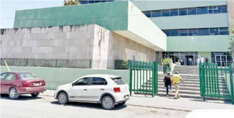
LA ACUMULACIÓN DE polvo tras seis meses sin limpieza redujo la capacidad de enfriamiento en los pisos superiores del hospital.
