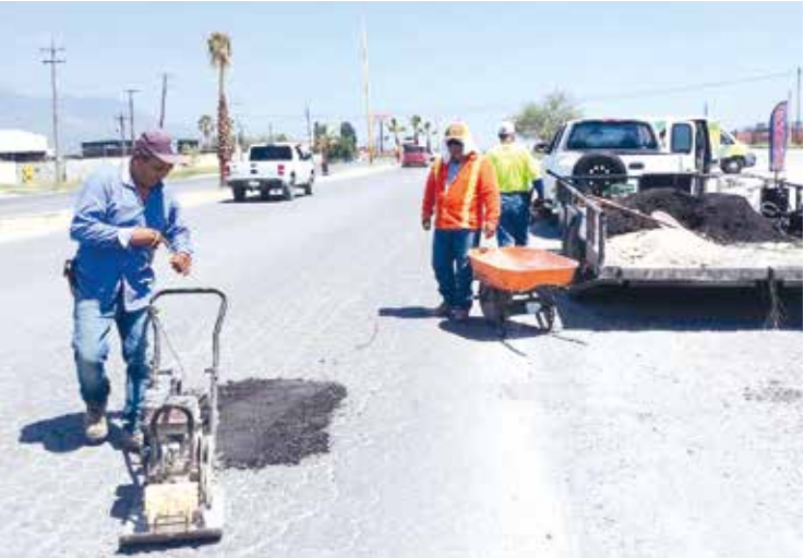
EL PROGRAMA DE Bacheo Permanente avanza con trabajos coordinados para conservar vialidades en mejores condiciones.
