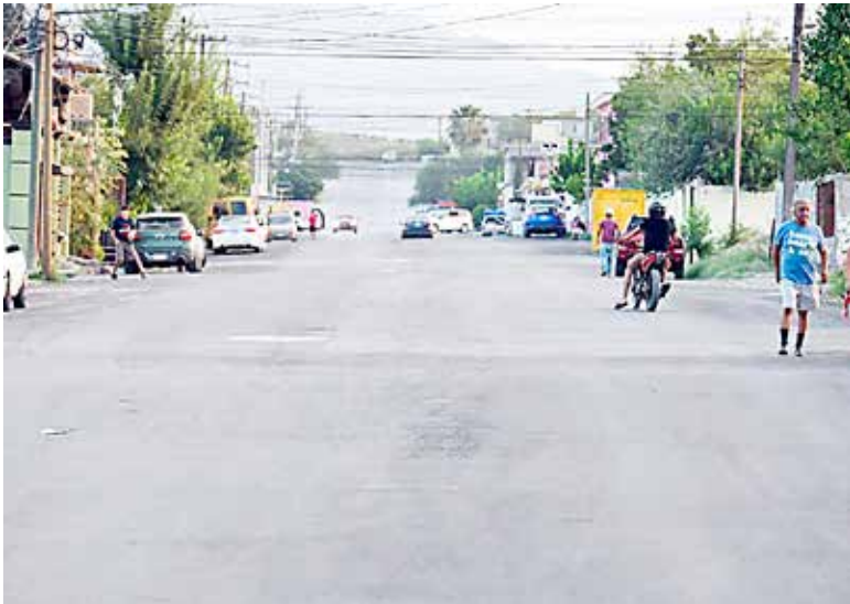
LA REHABILITACIÓN FUE de 8,927.91 metros cuadrados de pavimento asfáltico en caliente y 536.14 metros lineales.
