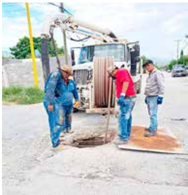
LA ALCALDESA YESICA Sifuentes destacó trabajos coordinados con SIMAS para fortalecer la infraestructura sanitaria y atender necesidades de las familias del municipio.
