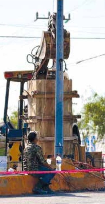
SOBRE EL BULEVAR Francisco Villa comenzaron trabajos para instalar un dispositivo que contribuirá a ordenar el tránsito y mejorar las condiciones de movilidad.
