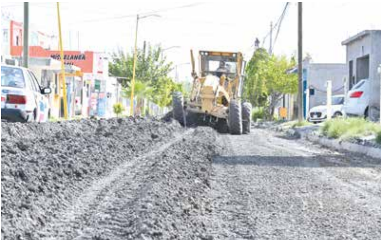
LOS TRABAJOS INCLUYEN preparación para carpeta asfáltica y recuperación del puente, con acciones desarrolladas después de atender fugas y afectaciones climáticas recientes en la zona.
