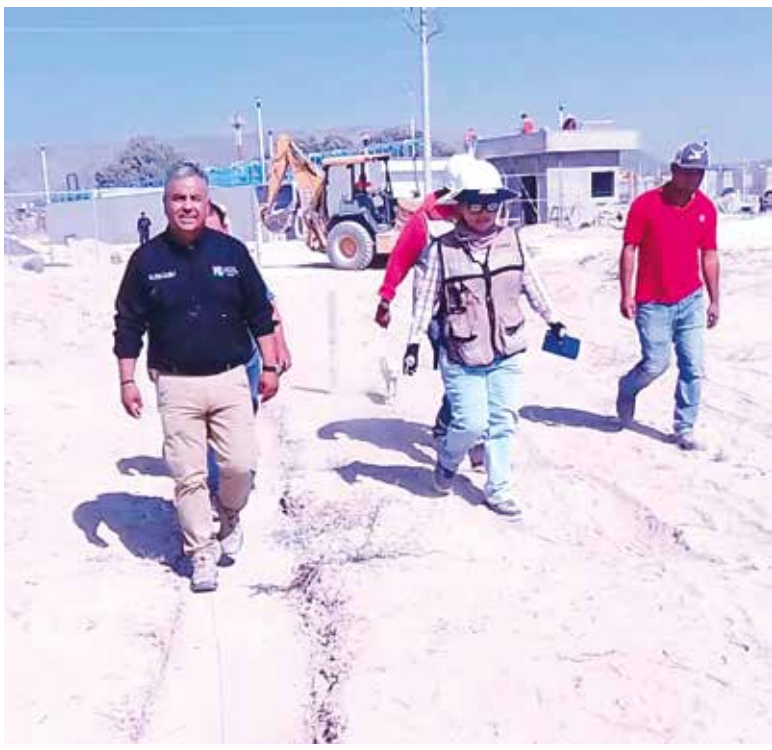
“ESTE RECORRIDO NOS permite conocer más detalles sobre los tiempos que lleva el proceso y verificar que realmente está funcionando. Será un proceso de prueba de varios días y, afortunadamente, está dando muy buen resultado”, señaló el Alcalde Víctor Leija.
