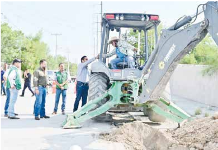
SUPERVISÓ LA OBRA de rehabilitación de la línea de agua en la Calle Álamo, entre Margarito Menor y Calle 1.
