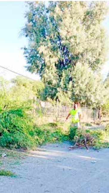
EL DEPARTAMENTO DE Servicios Primarios desarrolla trabajos en diversos sectores de San Buenaventura.
