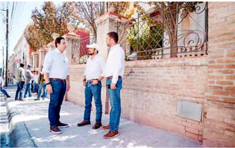
LA REHABILITACIÓN DE banquetas en la Calle Miguel Hidalgo se hizo en el tramo entre Mariano Escobedo y Juárez, trabajos que hasta el momento tienen un 95 por ciento de avance.
