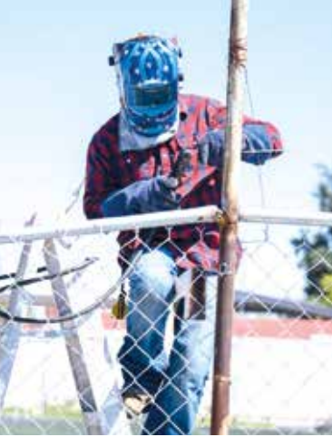
LOS TRABAJOS DE mantenimiento se dieron a la cancha deportiva de la Colonia Libertad.
