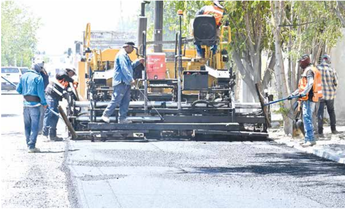
LA OBRA AVANZA hacia su conclusión, tras atender modificaciones en drenaje, tomas domiciliarias y retrasos ocasionados por las lluvias.
