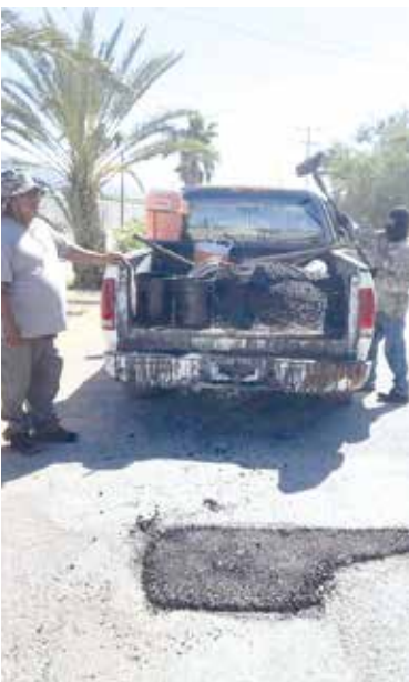
EL ALCALDE VÍCTOR Manuel Leija afirmó que el mantenimiento continúa como una tarea constante para responder a necesidades de infraestructura planteadas por habitantes.
