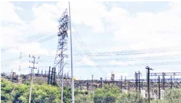
EN EL TERRENO de la colonia Obrera Norte se proyectaba la instalación de la Central Turbogas Monclova.
