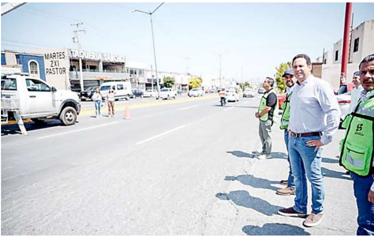
TAMBIÉN SE REPARARON luminarias, se realizó barrido manual y mecánico, reforestación, así como la rehabilitación de la carpeta asfáltica para mejorar la movilidad.
