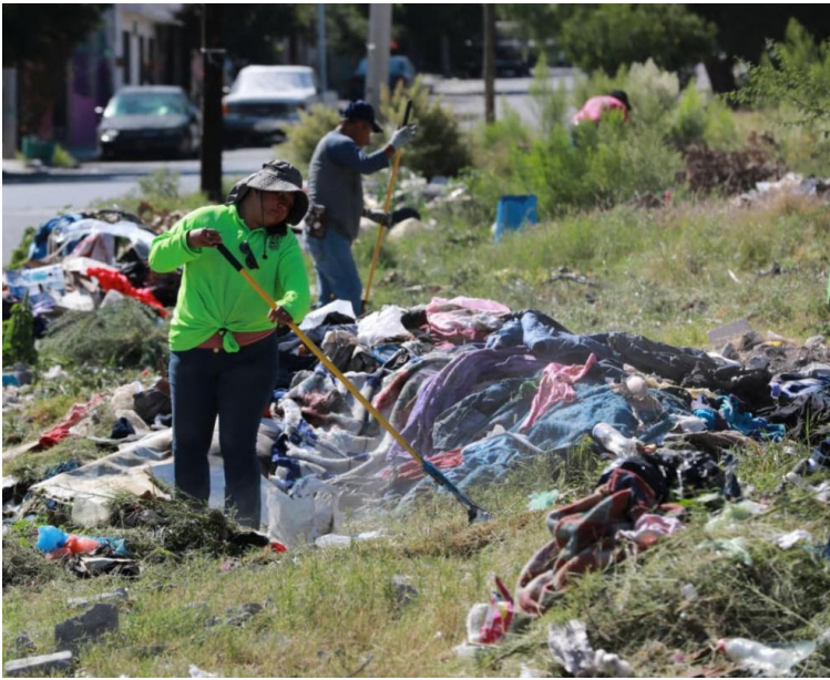
EN BENEFICIO DE cientos de familias, el Alcalde Javier Díaz instruyó trabajos de limpieza profunda, deshierbe y retiro de desechos en el canal pluvial.
