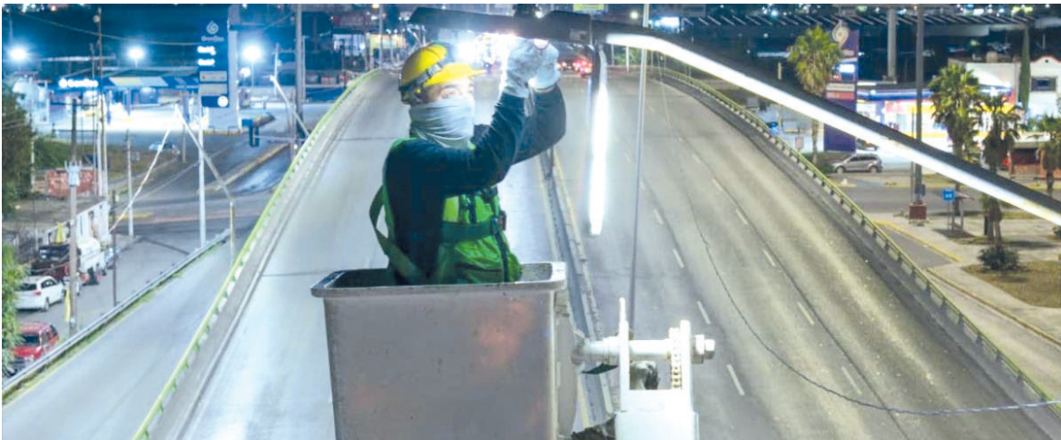
EL AYUNTAMIENTO DE Saltillo avanza en la instalación de nuevas luminarias, con lo que se fortalece la iluminación y se generan mejores condiciones de seguridad, especialmente, durante la noche.
