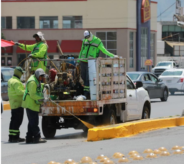
SE LLEVARON A cabo trabajos de aplicación de pintura amarilla en los cordones cuneta y camellón del Periférico Luis Echeverría Álvarez.
