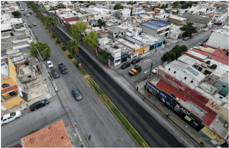
EL GOBIERNO MUNICIPAL mantiene trabajos de rehabilitación en calles y bulevares de diferentes sectores de Saltillo, a fin de brindar vialidades en mejores condiciones para la ciudadanía.
