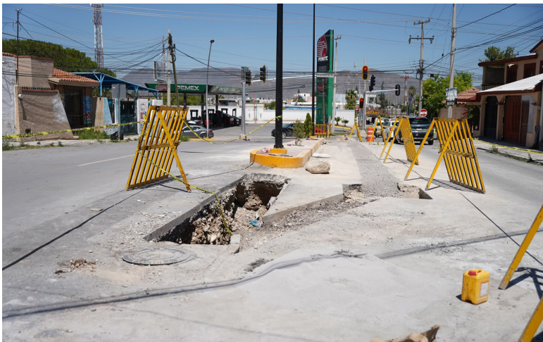
ENTRE LAS ACCIONES en proceso se encuentra el cambio de 40 metros de línea hidráulica en la prolongación Bulevar Del Valle y Bulevar Jaime Benavides Pompa.
