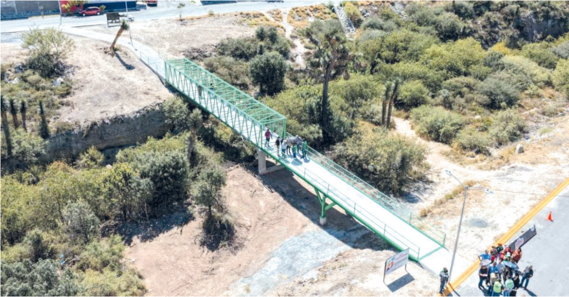
EN ESTE PUENTE se invirtieron 2.4 millones de pesos para brindar mayor seguridad a quienes cruzan por el arroyo de esa zona.
