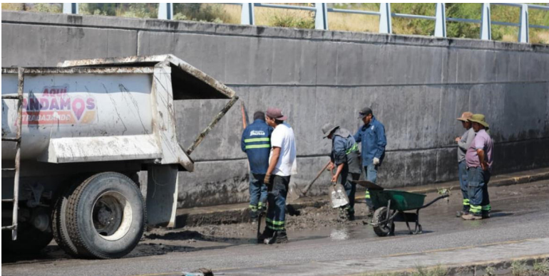
SE REALIZÓ UNA jornada de desazolve y limpieza de alcantarillas y rejillas pluviales, en puntos estratégicos del Periférico Luis Echeverría Álvarez, a la altura de la Colonia La Joyita, y en las “Curvas de la Landín”.
