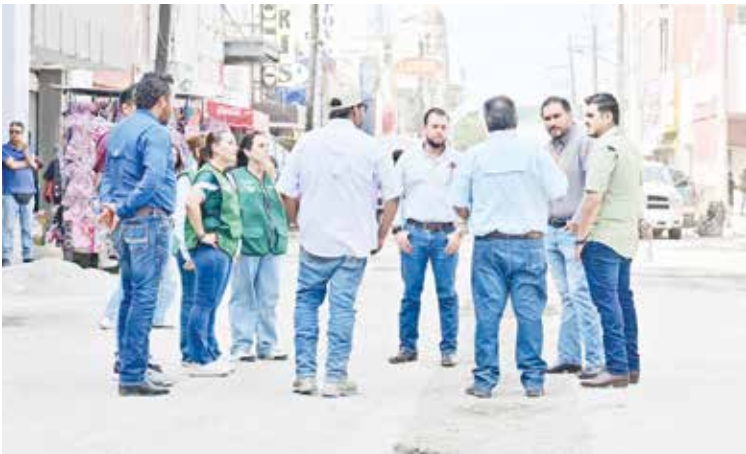
REALIZÓ CARLOS VILLARREAL la supervisión de la obra de rehabilitación de la red de drenaje de la Calle Hidalgo, entre Miguel Blanco y Abasolo, en la Zona Centro.
