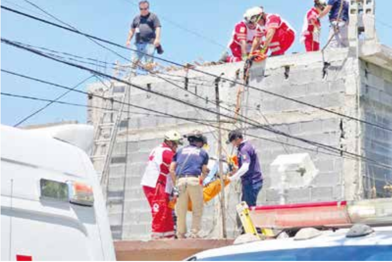
EL ALBAÑIL TRABAJABA en el techo de una casa.
