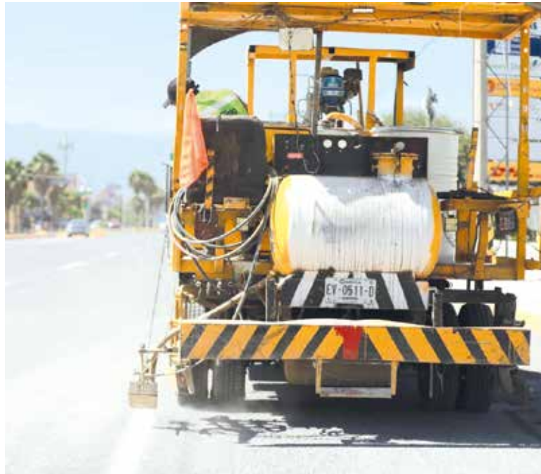
AVANZAN TRABAJOS DE rehabilitación vial en Saltillo.
