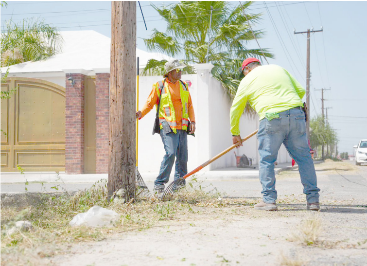
LOS TRABAJOS DE barrido y desbroce en camellones centrales garantizan un tránsito más seguro para los automovilistas que circulan diariamente.
