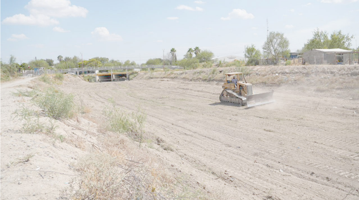
CUADRILLAS OPERATIVAS RECORREN los puntos críticos de la ciudad para liberar los drenes de basura y evitar afectaciones en colonias vulnerables.
