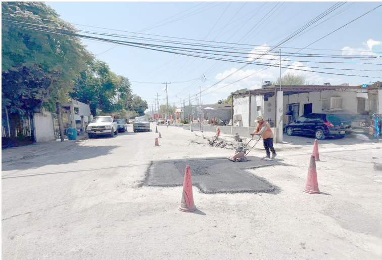
PERSONAL DE LA Dirección de Obras Públicas realiza maniobras sobre la arteria Francisco I. Madero y esquinas del sector centro.
