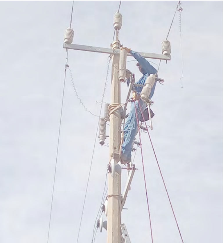
CUADRILLAS TÉCNICAS DE la Comisión Federal de Electricidad trabajaron en el área de captación para reparar el suministro eléctrico en los equipos de extracción.
