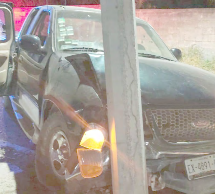
PERITOS EVALÚAN EL monto de los desperfectos ocasionados en el tendido eléctrico del cruce Zaragoza y Cuauhtémoc.
