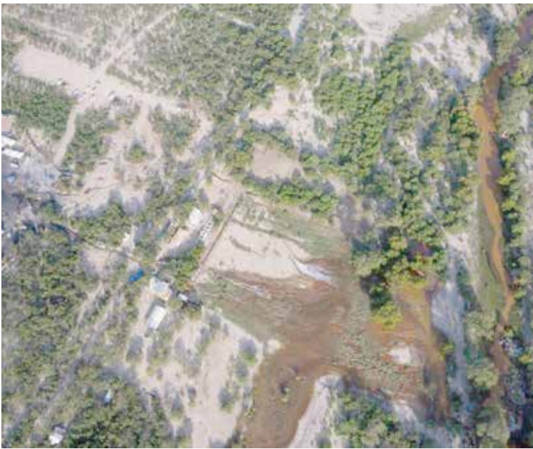
CUADRILLAS DEL AYUNTAMIENTO colaborarán en las maniobras técnicas para tapar los puntos donde escapa el agua residual.
