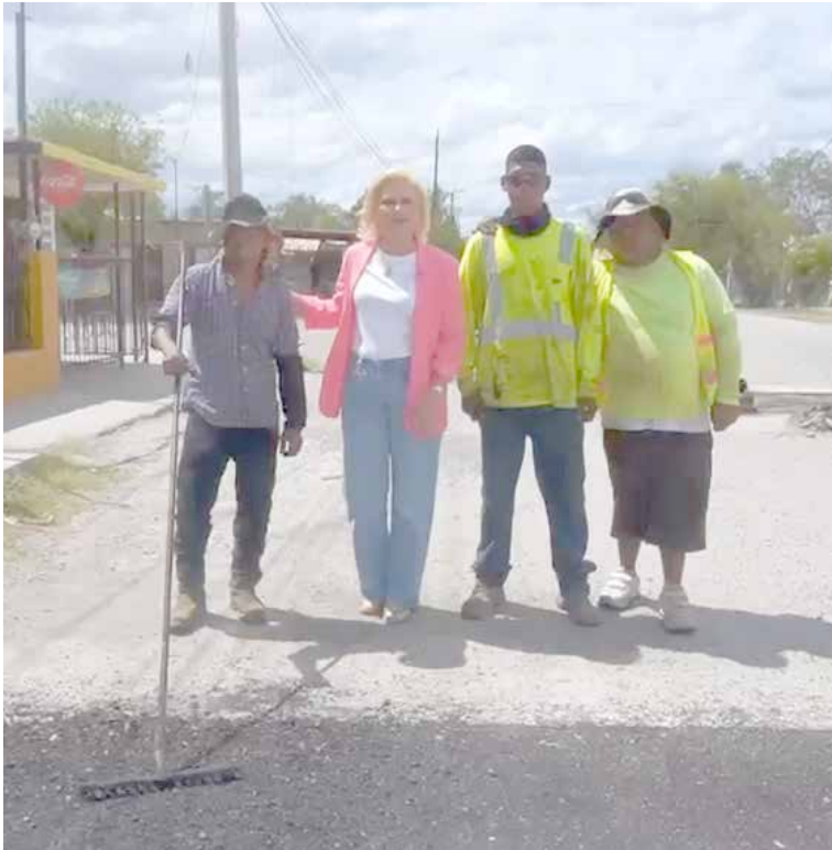
MAQUINARIA Y PERSONAL arrancan la atención a calles deterioradas en las comunidades alejadas de la cabecera.
