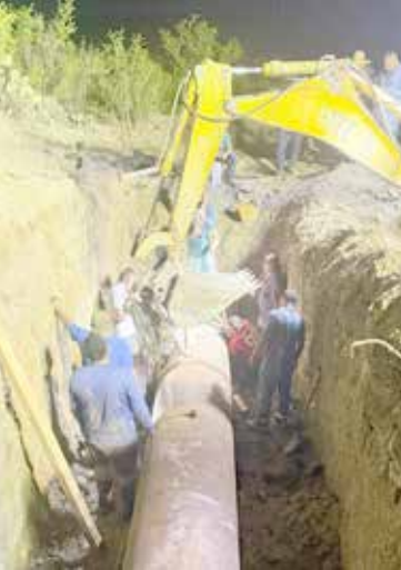
SIMARC AVANZA EN recuperación del suministro de agua.
