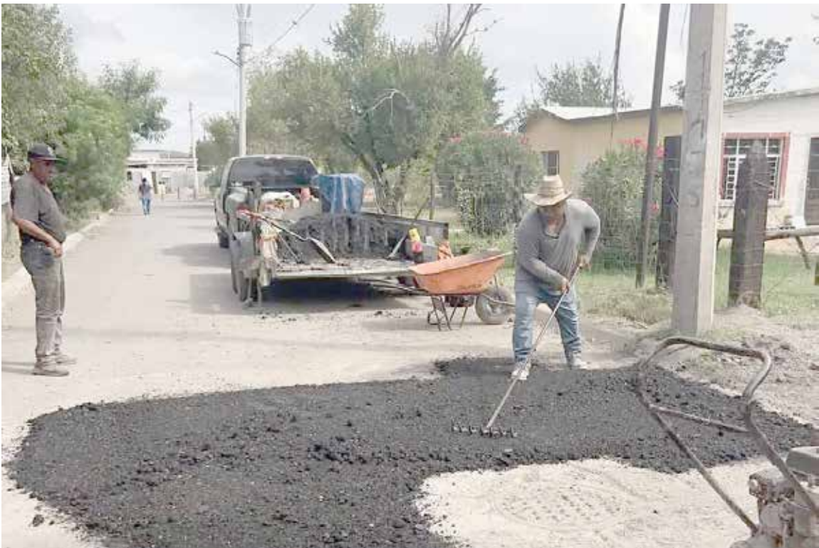
EQUIPOS DE TRABAJO rehabilitan la superficie de rodamiento en vialidades prioritarias señaladas por los vecinos.
