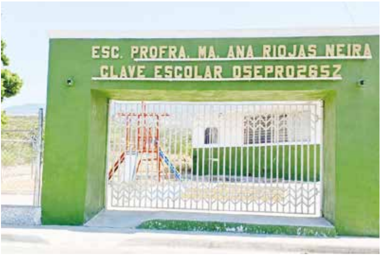
EL ROBO DE cableado y la falla en la subestación dejaron sin energía eléctrica a la primaria Mariana Riojas Negrete, obligando a los alumnos a tomar clases en línea.
