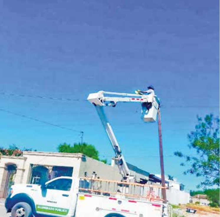
TRABAJADORES MUNICIPALES DE Monclova realizaron la rehabilitación de 9 circuitos de alumbrado público y el reemplazo de 3 luminarias.
