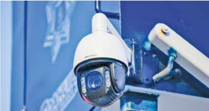
LA INFRAESTRUCTURA PUESTA en marcha fortalece la prevención, proximidad y capacidad operativa en el área Centro-Desierto.
