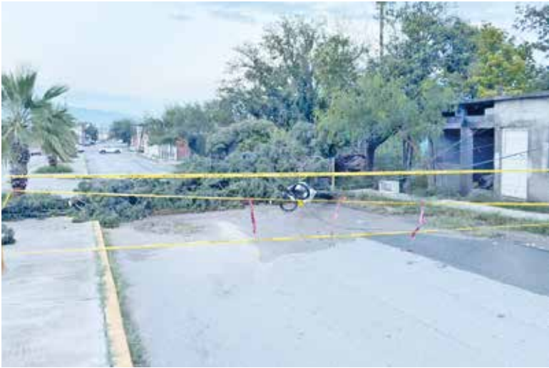
PESE A LOS destrozos en la infraestructura urbana y bardas particulares, las autoridades descartan personas lesionadas.
