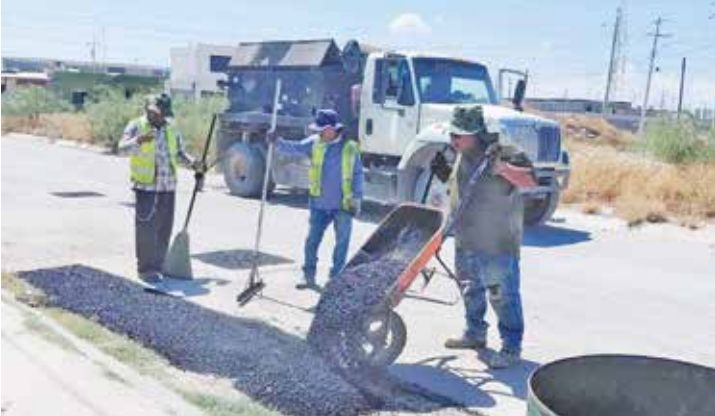
DURANTE LA SEMANA se repararon 649 baches y 37 roturas de red de agua en distintos sectores de Monclova.
